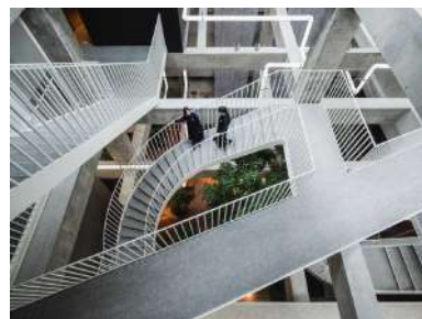
宿泊のお客様のみ利用可能な吹き抜けのブリッジと階段 ©Katsumasa Tanaka
